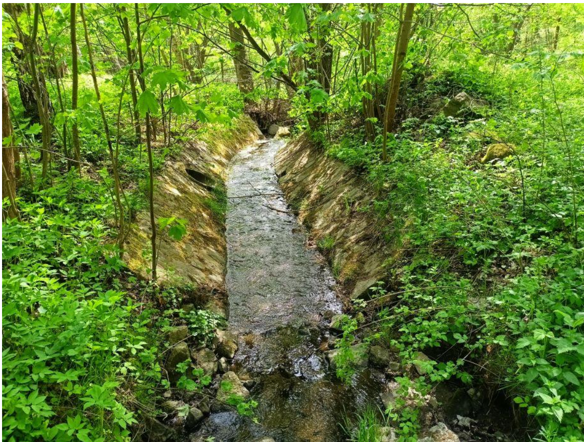
Obrázek 12 opevnění břehů a dna potoka v místě plánované přeložky toku
